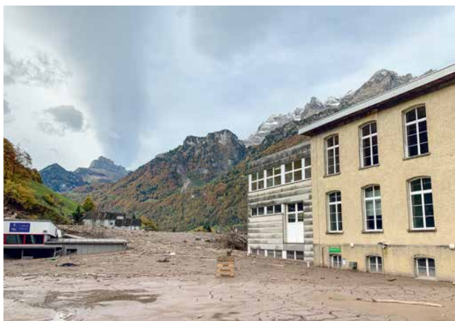
Les glissements de terrain dans le canton de Glaris ont touché bien des bâtiments, dont l'office de distribution de Schwanden.
