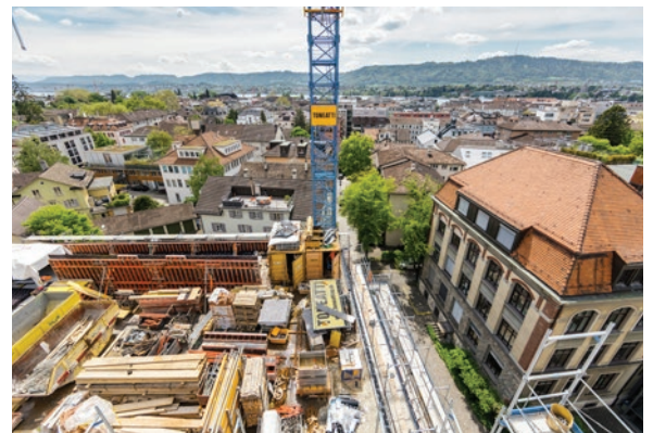
Beaucoup de matériel, peu d'espace: une synchronisation optimale est indispensable sur le chantier de la Kreuzplatz.
