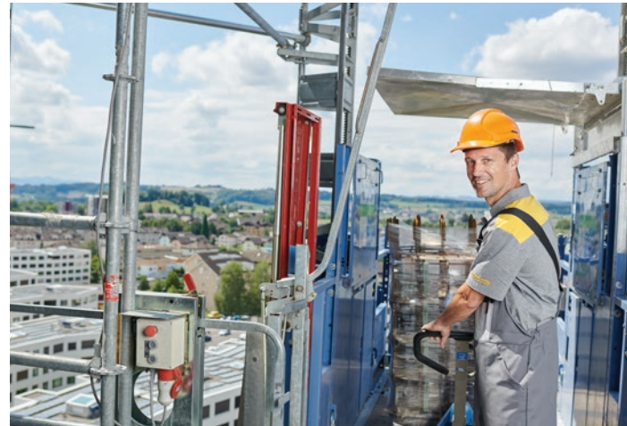
Vue depuis l'ascenseur sur le grand chantier à Rotkreuz où la Poste est chargée des processus logistiques.
