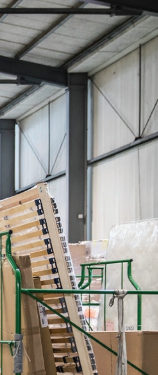
Pascal Schmalz contrôle si la maintenance de l'extincteur a été assurée correctement.
