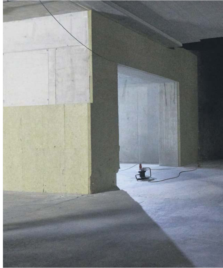
A la station multifonctions, on a davantage l'impression d'être dans un bâtiment industriel hydraulique qui produit de l'électricité pour 150 foyers.
