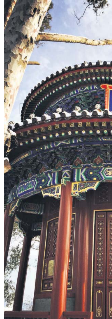
Temple sur la Colline de Charbon qui surplombe
