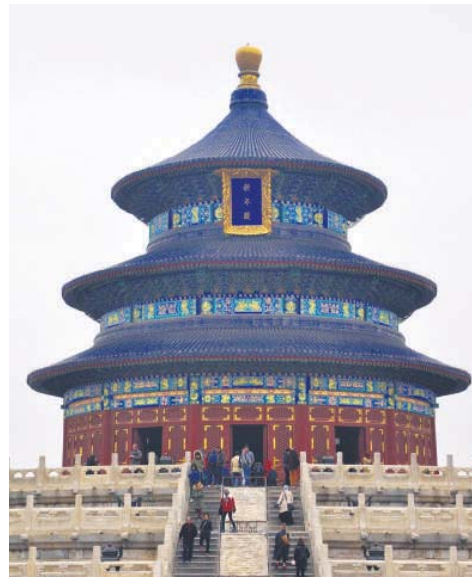
Le Temple du ciel est le symbole du tourisme pékinois. La forteresse a été bâtie de manière à valoriser le chiffre 9 et le dragon, emblème impérial. La pagode au triple toit de tuiles bleues a été construite sans un clou.
