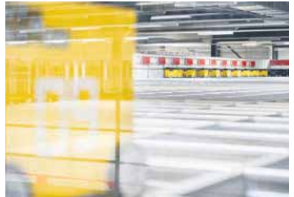
Lorsque les petits robots ne sont pas en service, ils sont sagement garés sur le bord de l'installation et se rechargent.
