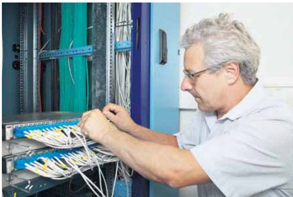
Marco Nessi termine le câblage d'un commutateur.
