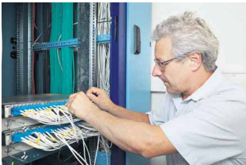
Marco Nessi schliesst einen Verteiler an.
